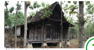
Abriss des Holzhauses
